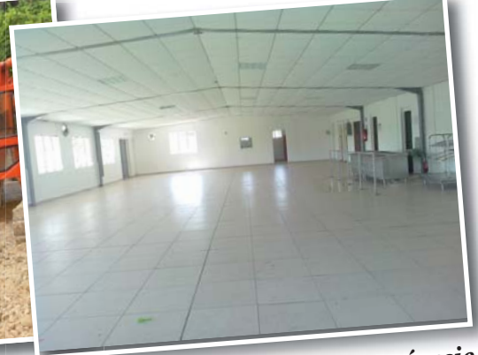
Pour une rentrée des classes réussie, commençons les travaux à la cantine !
